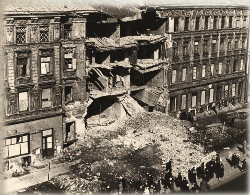
Разрушенный дом в центре Ленинграда 1944г.
