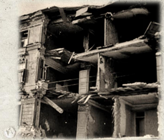
Разрушенный дом в центре Ленинграда 1944г.
